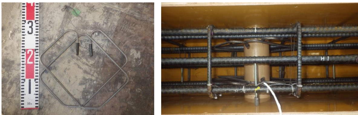
図 1-2 開口補強金物とその配筋例
