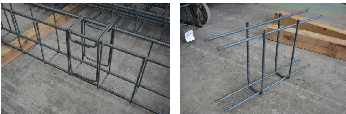
図 1-3 溶接組立鉄筋とキャップタイを利用した開口補強筋
