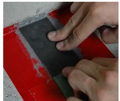
CFRP 板の貼付
