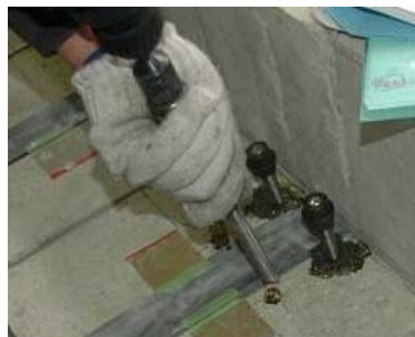
アンカーボルトの埋め込み
