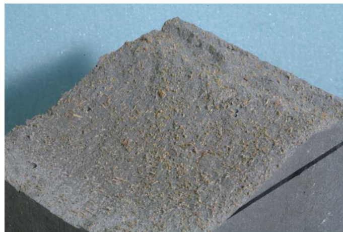
写真 3.8 曲げ試験体のひび割れ面
