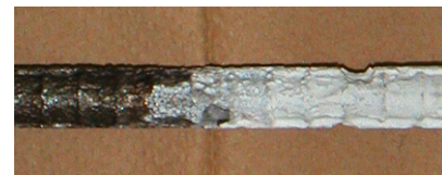
図-14 白色塗料塗布状況
