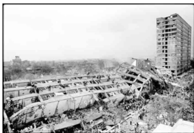
図 1 メキシコ地震で倒壊した建物 (写真: Marco Antonio Cruz)
