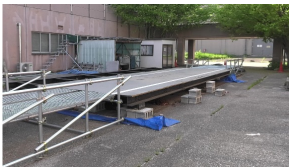
図 4-1 鋼製橋梁外観
