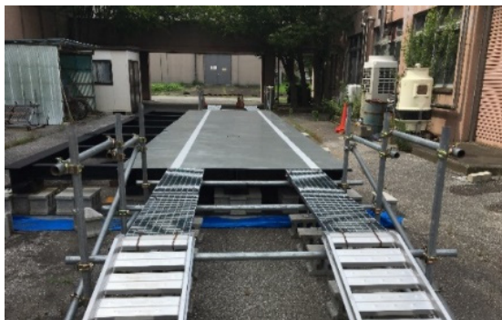
図1 鋼製橋梁外観
