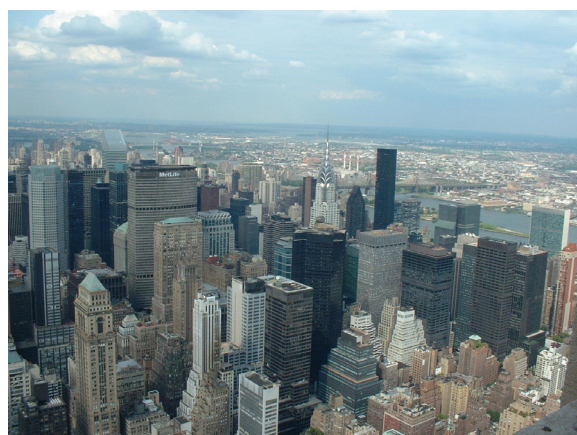
図-1.1.1 ニューヨークのマンハッタン地区 ここに超高層ビルが早くから建てられたのは、地盤が強固な岩盤だったため。東京でも新宿などの山の手は地盤がよいが、上野などの下町は地盤が弱いため最近になるまで超高層ビルは建てられなかった。
