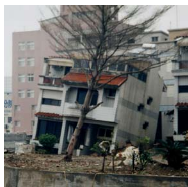
図-1.2.2 上 液状化は実験室で簡単に再現することができる。水中で緩く堆積させた地盤模型の表面に建物模型を置き、振動を加えると、地盤が液状化して建物がズブズブ沈む。海岸線沿いで堤防が地震で破壊されていると、広い地域で、土砂が海側に流動する。 下 液状化で傾いた建物
