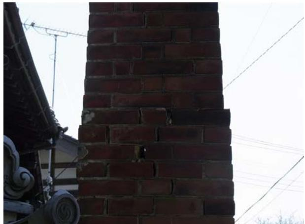
写真5 倒壊の危険性があるレンガ造りの煙突（牛渡地区）
