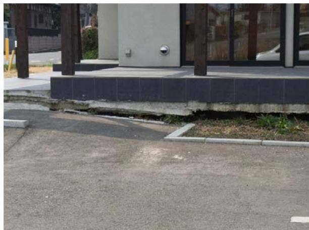
写真 26 地盤沈下で生じた店舗の被害（下平柳地区）
