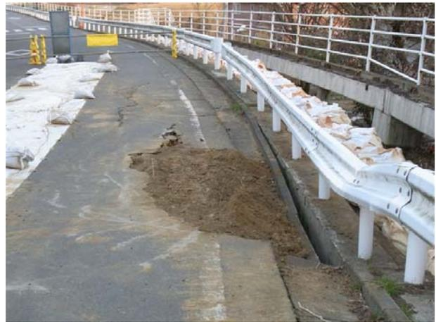
写真 19 道路の陥没と側道の落下（高浜地区）
