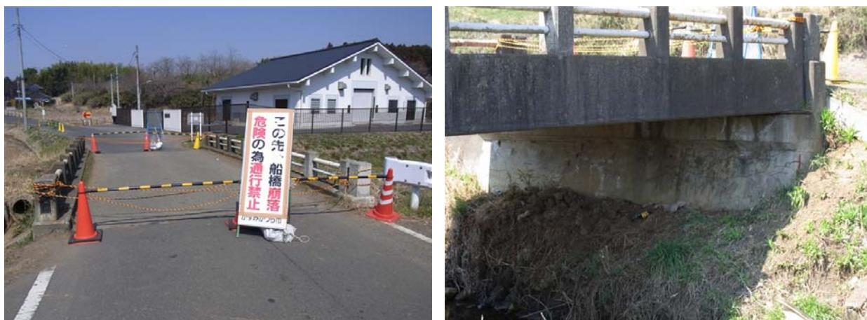
写真1 崩落の危険性がある橋（橋台に多数のひび割れ）
