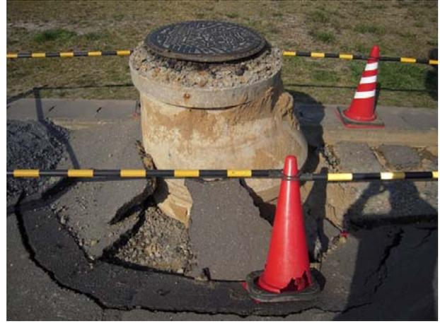
写真7 液状化による歩道の被害①（駅東口）
