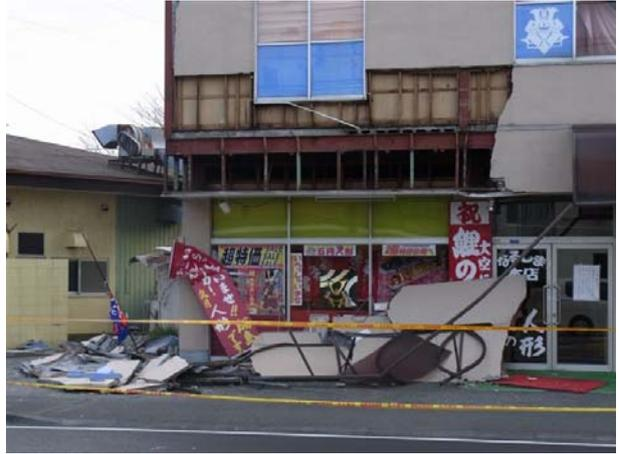
写真 27 外壁が落下した店舗の被害（馴馬町地区）
