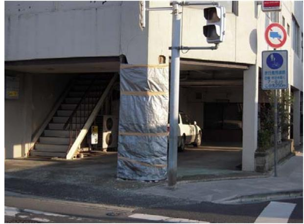
写真 13 ねじれによる柱の被害（駅西口）
