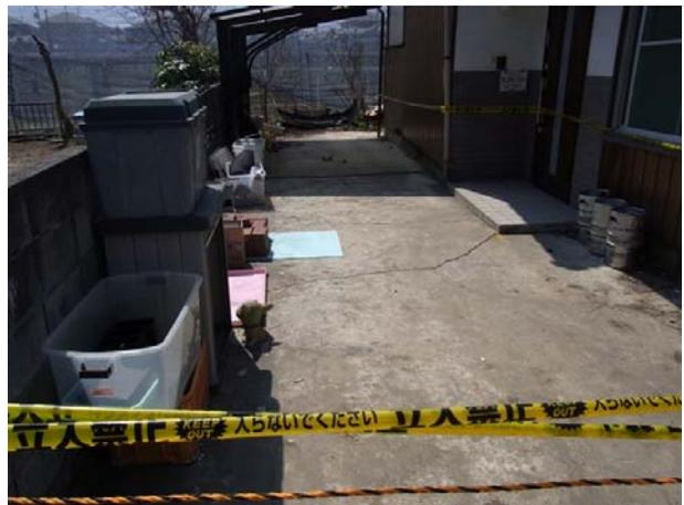
写真4 地割れが建物真下を通り傾いた住宅（下稲吉南地区）→ 全壊
