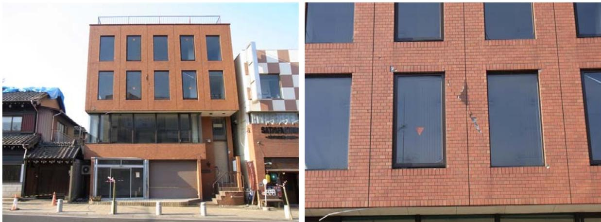
写真 17 外壁のせん断ひび割れ（駅西口）
