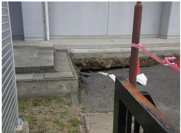
写真 28 地盤沈下による中学校の被害（光順田地区）
