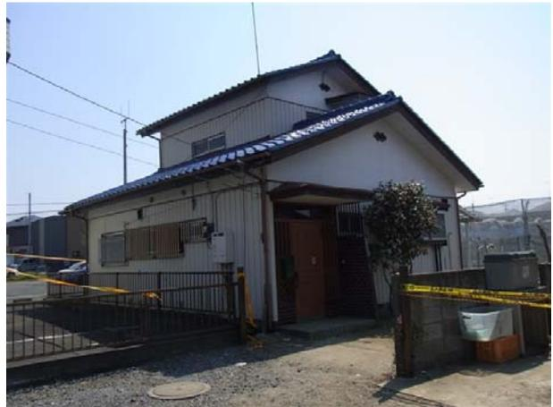
写真3 地割れが建物真下を通り傾いた住宅（下稲吉南地区）→ 全壊
