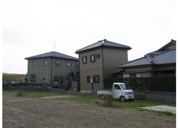
写真 24 液状化により傾いた住宅（下平柳地区）
