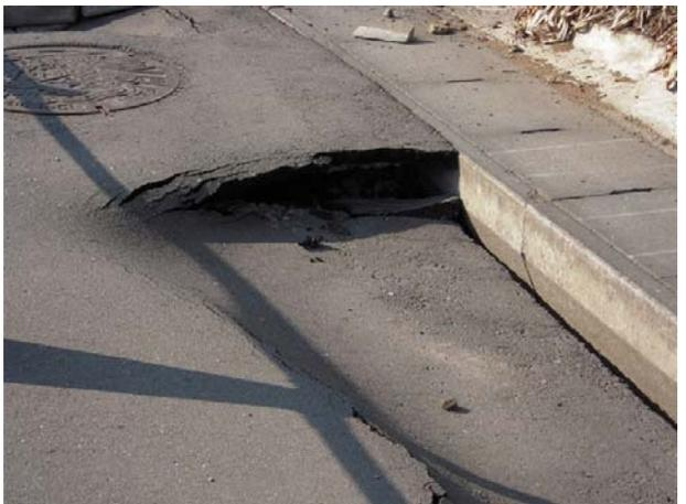
写真8 外壁が落下した店舗兼住宅および地盤の沈下（駅東口）
