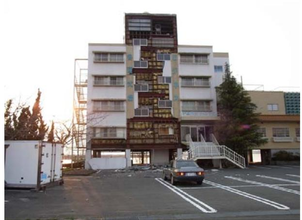
写真 30 外壁が落下したホテル（佐貫町地区）
