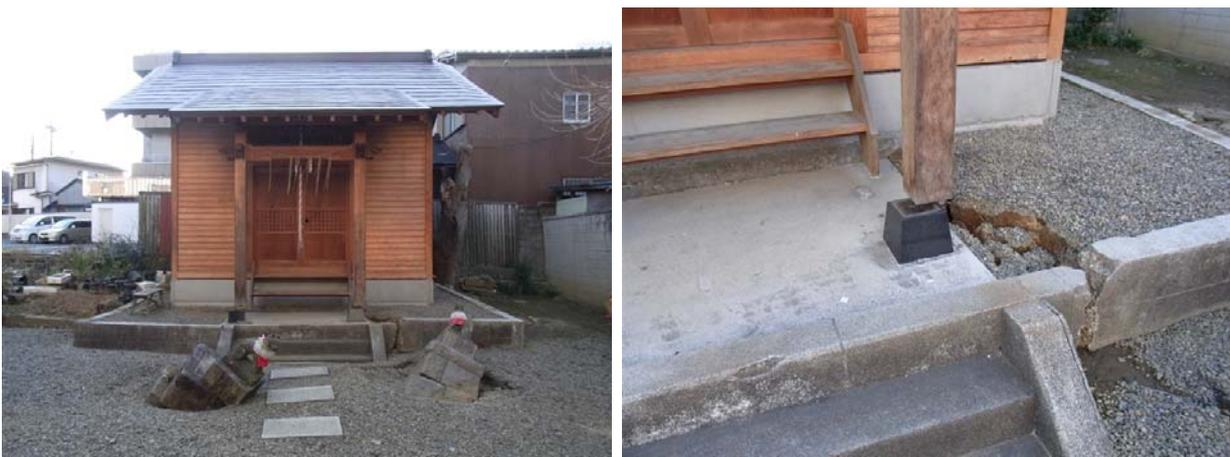
写真 18 液状化による地盤沈下（駅西口）
