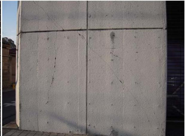
写真 11 RC 造オフィスビルの被害（駅西口） → 全体的にひび割れ多数
