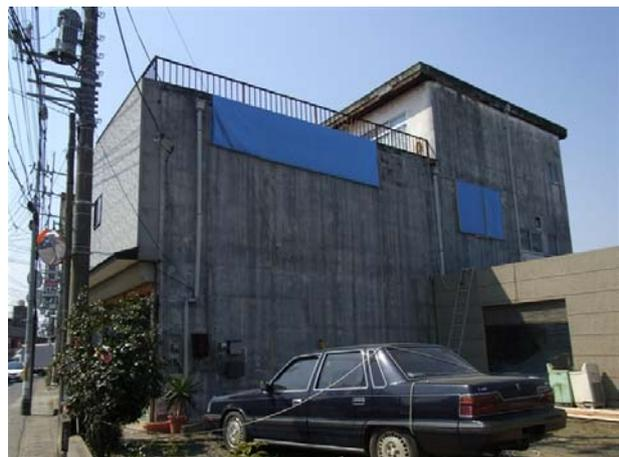
写真2 半壊した店舗兼住宅（稲吉地区）→ 外壁落下，ガラス破損
