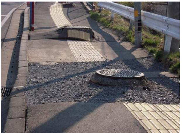
写真10 液状化による歩道の被害②（駅東口）
