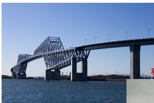
東京ゲートブリッジ
