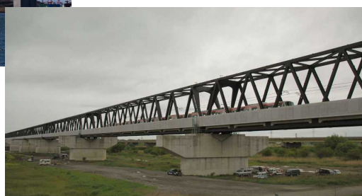
利根川橋梁(つくばエクスプレス)
