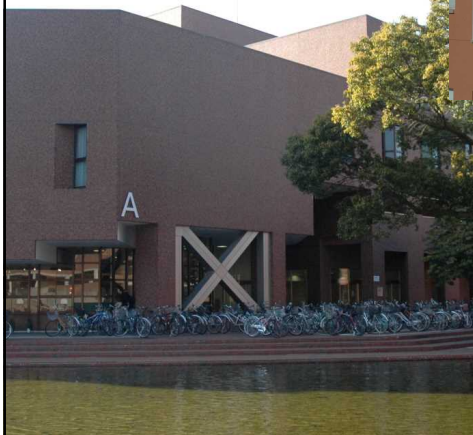
筑波大学校舎の 鉄骨ブレース
