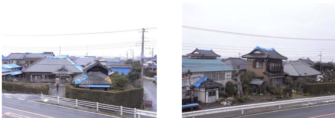
写真 4 住宅屋根の瓦の落下（脱落）（押砂地区）
