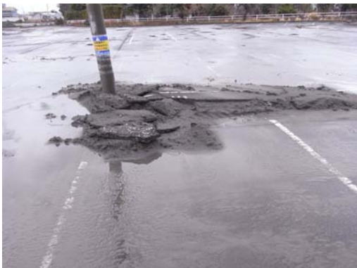
写真 12 ショッピングセンター駐車場における液状化 (西代地区)
