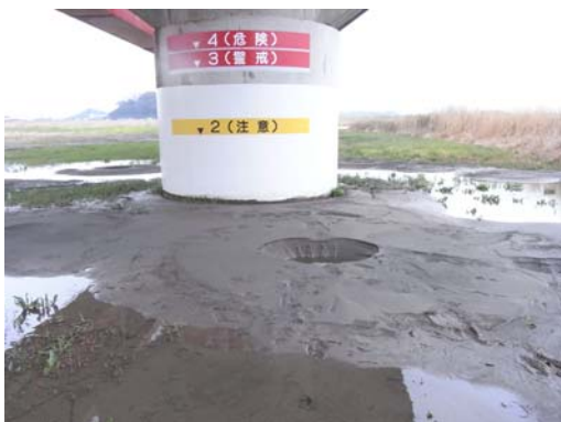
写真 14 橋脚付近の液状化（橋向地区）
