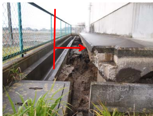
写真 17 体育館周辺の地盤の液状化と水平移動 (金江津地区、金江津中学校)
