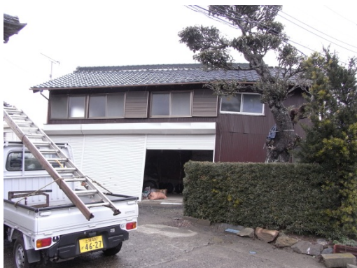
写真 2 地盤沈下による住宅の傾き(結佐地区)
