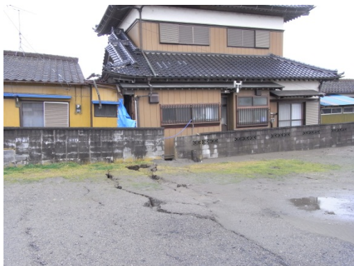
写真 1 地盤の地割れおよび沈下による住宅の傾き（上之島地区）
