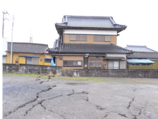
写真 1 地盤の地割れおよび沈下による住宅の傾き（上之島地区）
