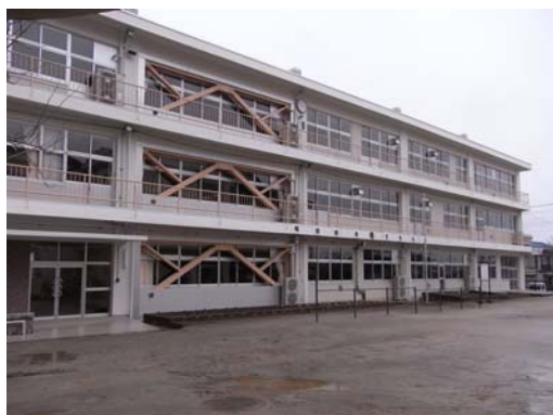
写真 9 耐震補強されたほぼ無被害の校舎棟（江戸崎小学校）
