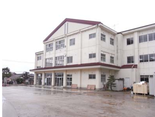
写真 9 耐震補強されたほぼ無被害の校舎棟（江戸崎小学校）
