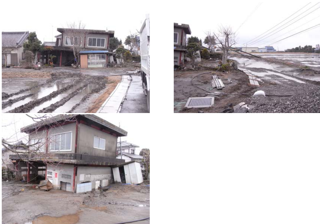
写真 3 地盤の液状化による建屋の沈下（六角地区）
