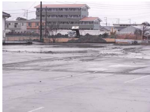
写真 12 ショッピングセンター駐車場における液状化 (西代地区)
