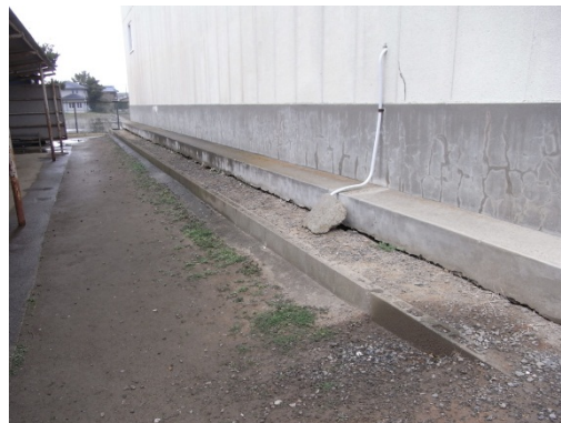
写真 8 地盤の沈下による体育館基礎との間に生じた隙間（あずま東小学校）
