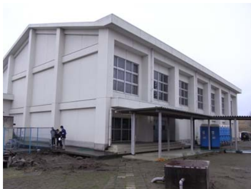
写真 17 体育館周辺の地盤の液状化と水平移動 (金江津地区、金江津中学校)
