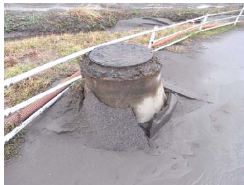
写真 13 地盤の液状化によるマンホールの浮き上がり（四ツ谷地区）
