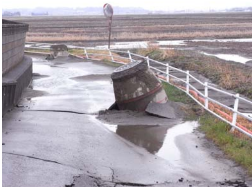
写真 13 地盤の液状化によるマンホールの浮き上がり（四ツ谷地区）
