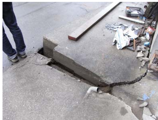
写真 2 地盤沈下による住宅の傾き(結佐地区)
