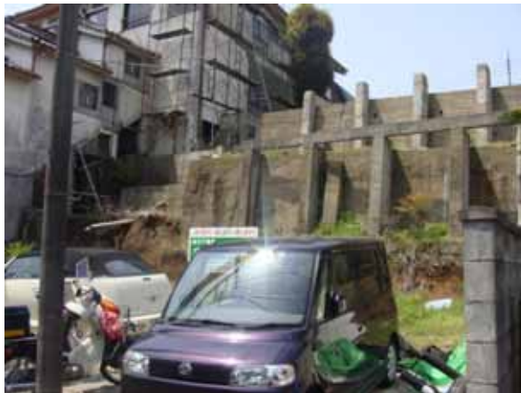
筑西市街 ，茨城県筑西市甲，4月27日 11:00 ， 周囲の擁壁一部崩壊 旅館，木造3階建て（複雑，一部RCの柱あり）傾斜地にたつ，中破・壁の脱落，瓦の落下等
