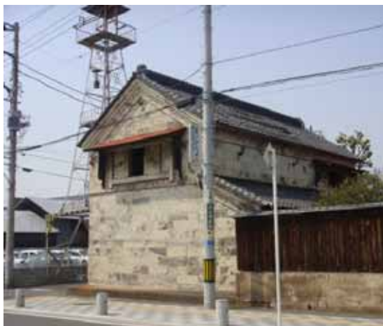
筑西市街 27，茨城県筑西市丙，4月27日 13:30 蔵，石造2階建て，小破・屋根瓦ずれ，目地のずれ，石材の割れ
