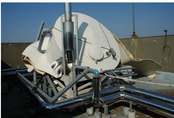
写真1 校舎のエキスパンションジョイント部の損傷，高架水槽の崩壊（架台は補強済み）
