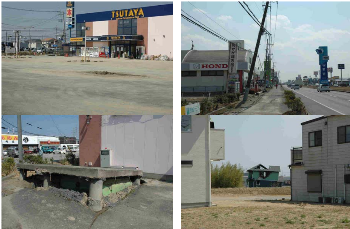
写真 8 液状化の被害
