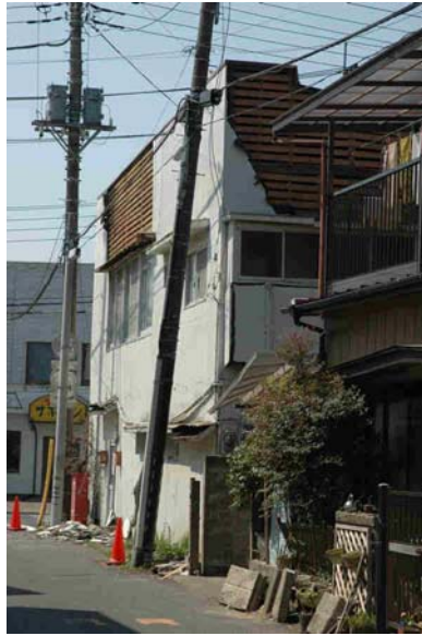
写真5 外壁パネルの崩落
