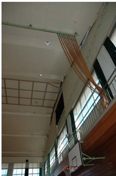
写真2 体育館の全景，天井パネルの損傷
