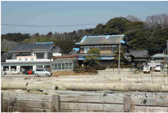
写真6 屋根瓦の被害
