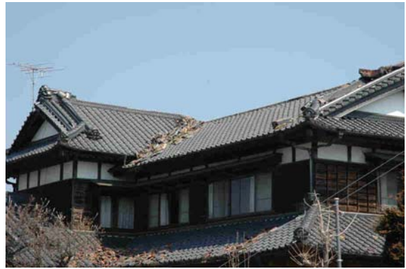
写真6 屋根瓦の被害
