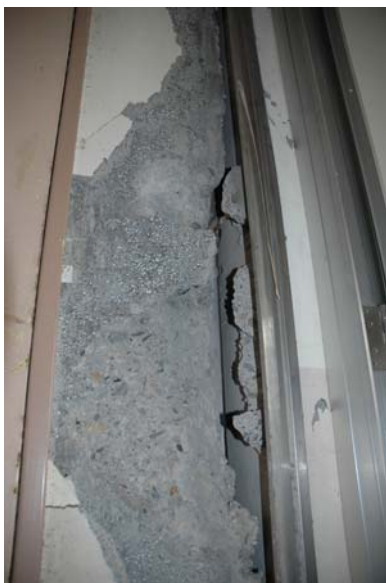
写真1 校舎のエキスパンションジョイント部の損傷，高架水槽の崩壊（架台は補強済み）
