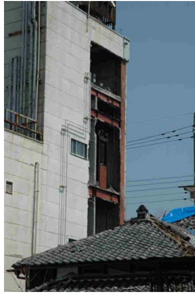
写真5 外壁パネルの崩落
