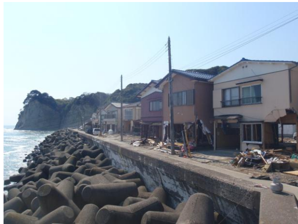
図7 護岸背後被災住宅
