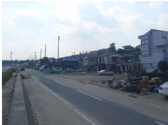
図 41 被災した建屋と堆砂
