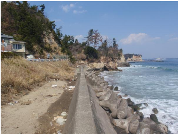
図 21 区間中央部から岬 B 方向の護岸とブロック
