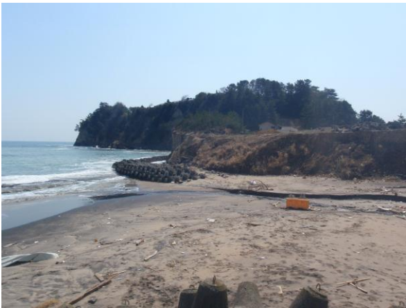
図 24 区間中央部から五浦方向の崖
