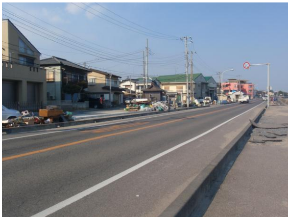
図 44 平磯漁港付近の建屋の被災
