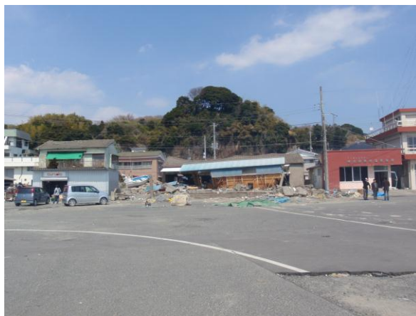
図 29 漁業協同組合付近（右端）の家屋の甚大な被害
