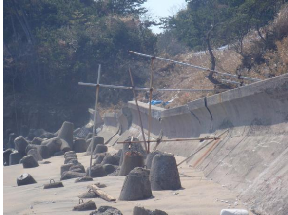
図 20 護岸の崩壊
