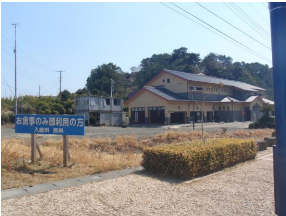
図 26 被災した温泉施設
