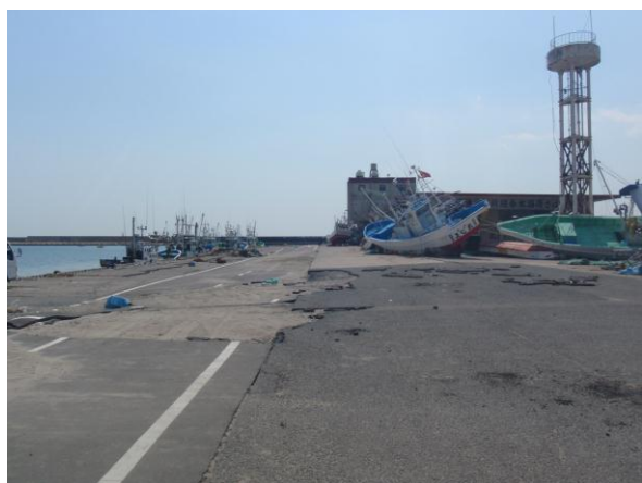
図 32 エプロン部のアスファルトの捲れ上がり
