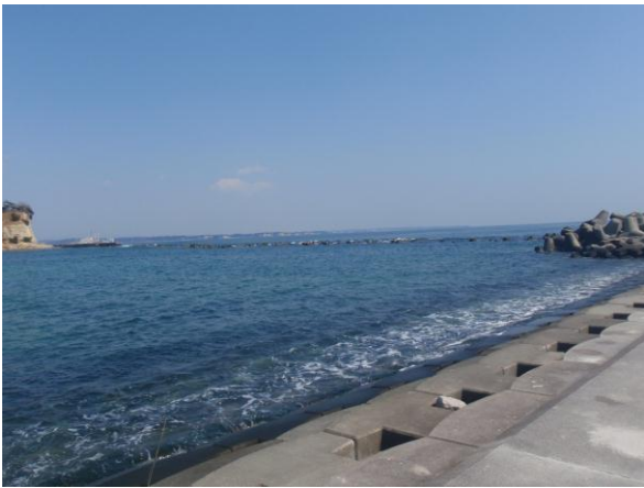
図 14 九ノ崎と突堤の沖にあるブロック積みの離岸堤
