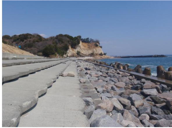
図 13 緩傾斜護岸と石積み堤
