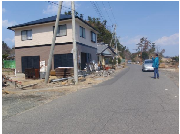
図 27 区間中央部の被災した家屋
