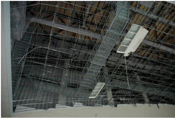
写真 32 残った野縁受けと落下したパネル
