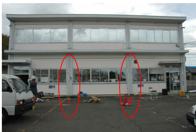
写真 6 第二庁舎の柱のせん断破壊（柱せい 600mm 程度，主筋 \phi 22 ，帯筋 \phi 9@250 ）
