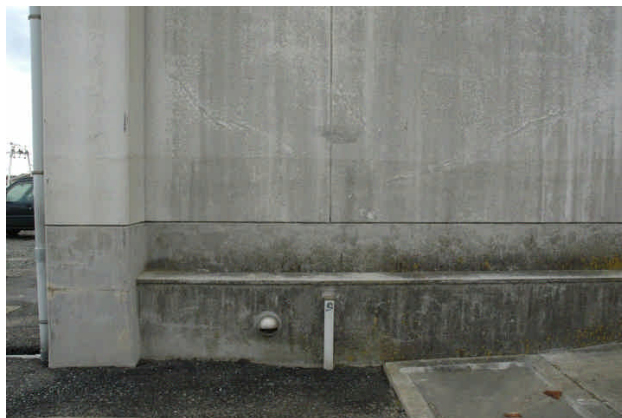
写真1 漁協建物の壁のせん断ひび割れ
