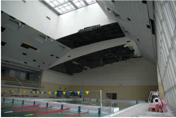
写真 31 天井パネルの大規模落下
