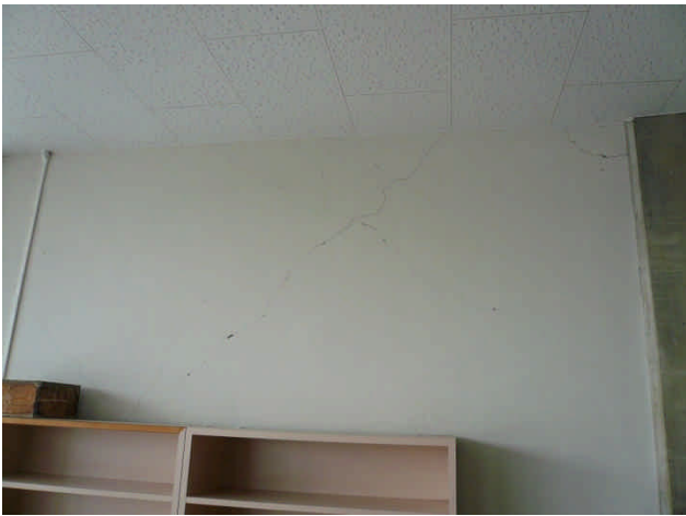
写真 14 日立市中央体育館の2階入口壁の損傷
