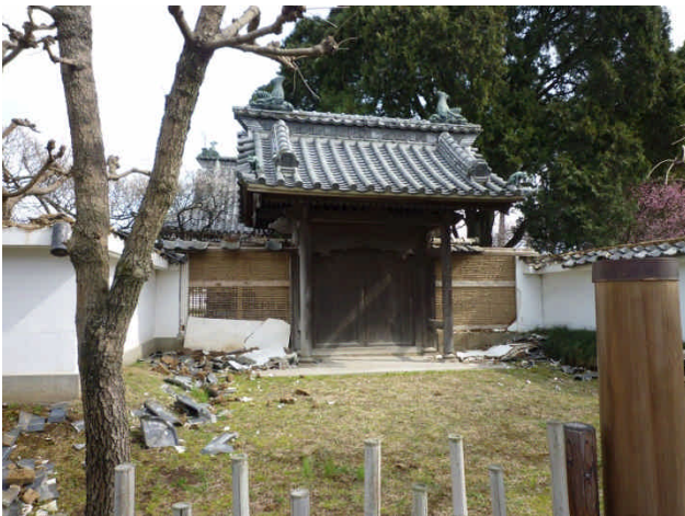
写真 28 弘道館公園の被害（左：孔子廟の外壁落下，右：学生警鐘の倒壊）
