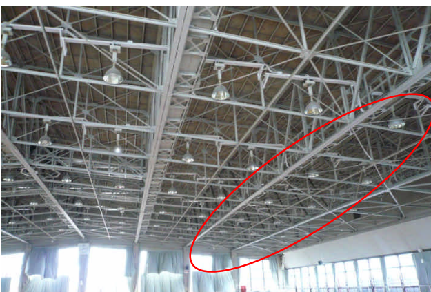
写真 13 日上市中央体育館の天井ブレースの損傷（左：座屈，右：破断）
