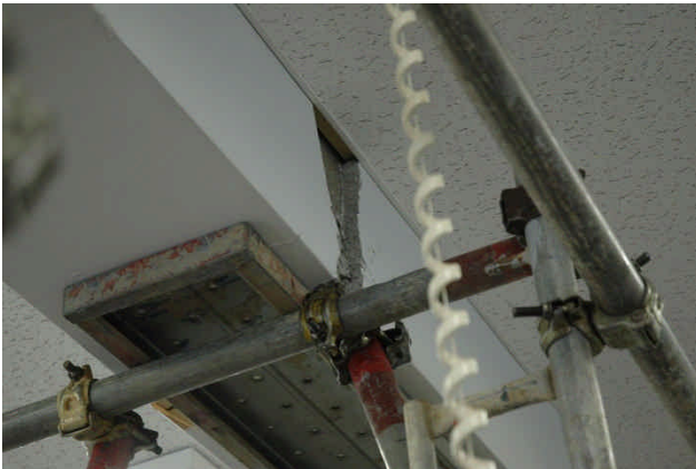
写真 22 常陸大宮土木事務所の梁および柱のひび割れ
