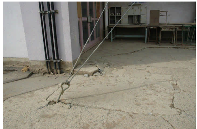
写真 29 水戸第一高校体育館の外観および基礎部の損傷
