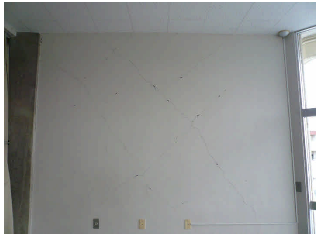
写真 14 日立市中央体育館の2階入口壁の損傷
