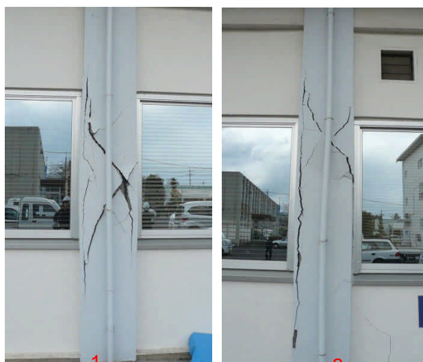
写真 6 第二庁舎の柱のせん断破壊（柱せい 600mm 程度，主筋 \phi 22 ，帯筋 \phi 9@250 ）
