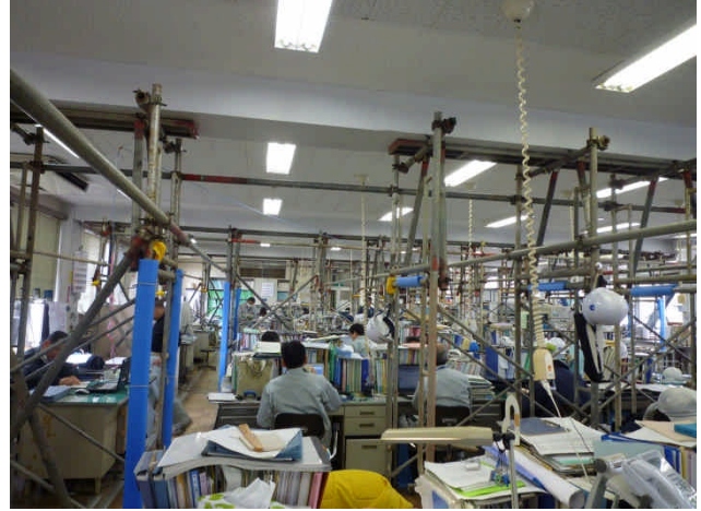
写真 21 常陸大宮土木事務所の外観および建物内補強
