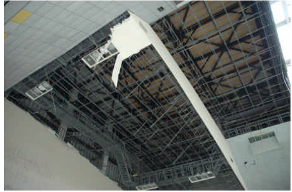
写真 31 天井パネルの大規模落下
