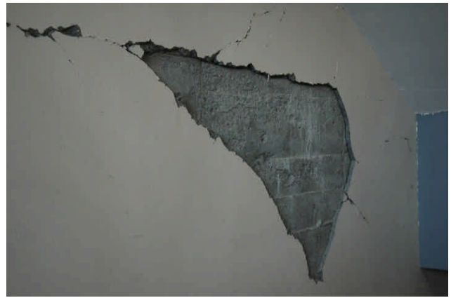
写真 27 大子町役場の壁のひび割れ
