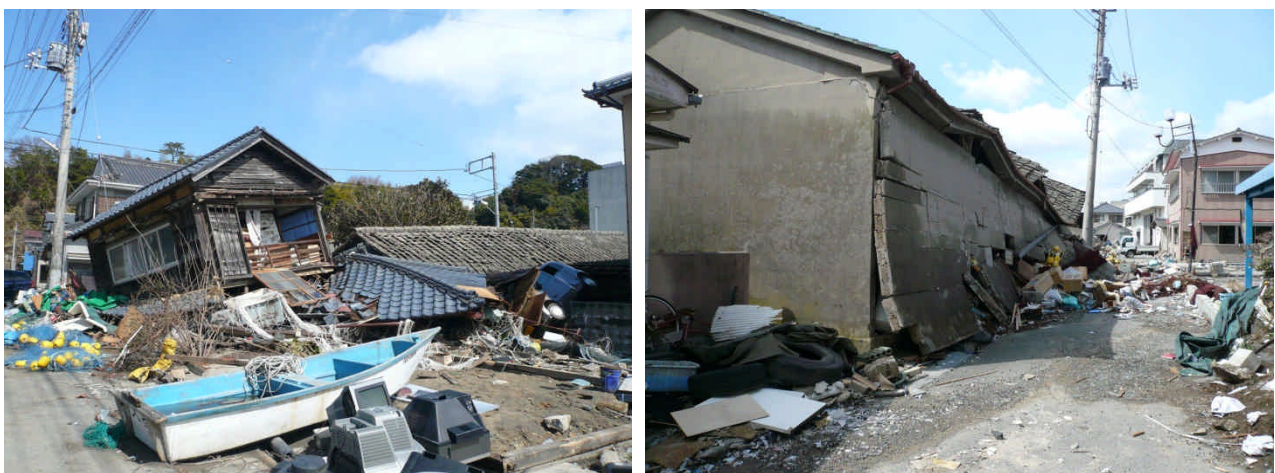
写真5 津波による住宅被害
