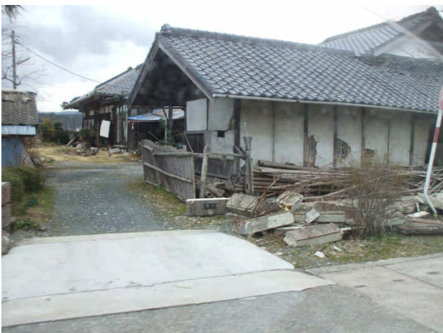
写真9 高萩市下手綱周辺の被害（戸建住宅，石積みの塀，蔵，瓦の損傷）
