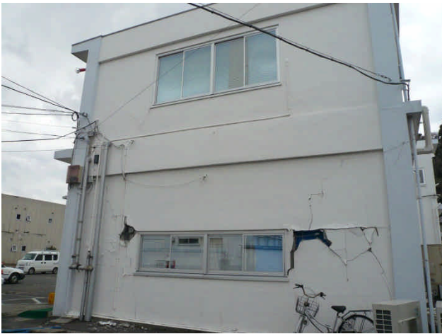
写真7 第二庁舎の壁の損傷
