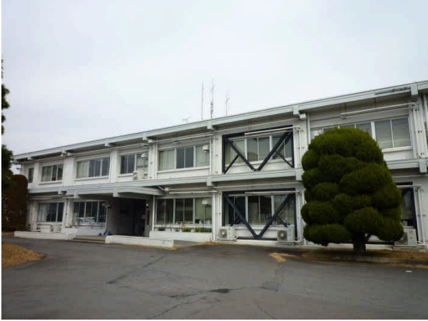
写真 21 常陸大宮土木事務所の外観および建物内補強
