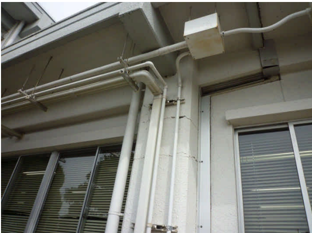
写真 23 常陸大宮土木事務所の柱の曲げひび割れおよび圧壊
