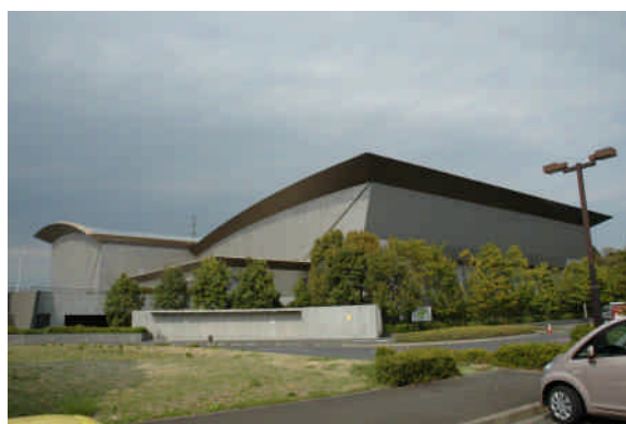
写真 30 屋内プール全景
