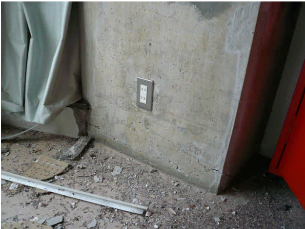
写真 12 日上市中央体育館の2階外柱の曲げひび割れおよびコンクリート圧壊
