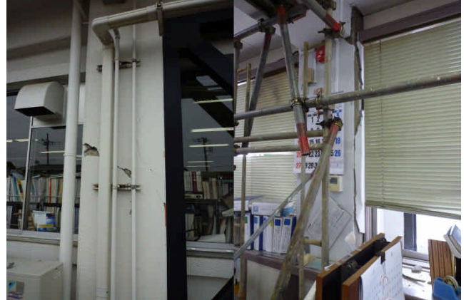
写真 22 常陸大宮土木事務所の梁および柱のひび割れ
