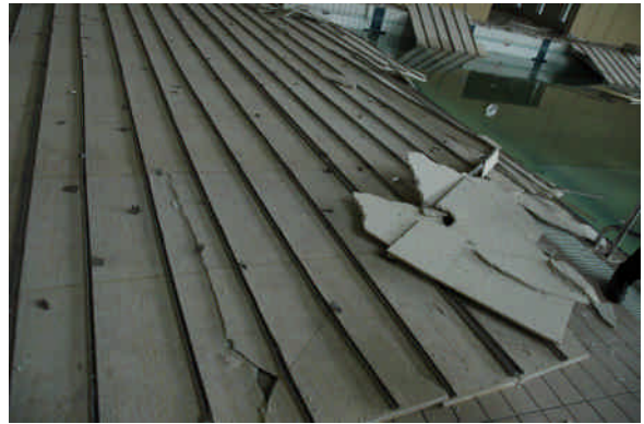
写真 32 残った野縁受けと落下したパネル
