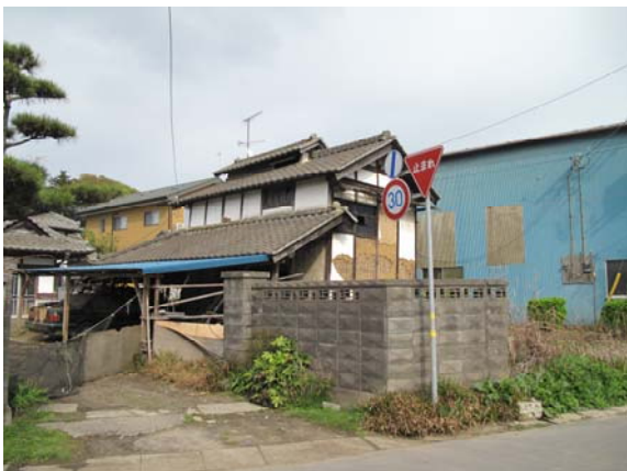
写真 37 外観斜め正面
