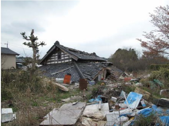
写真 30 外観斜め正面
