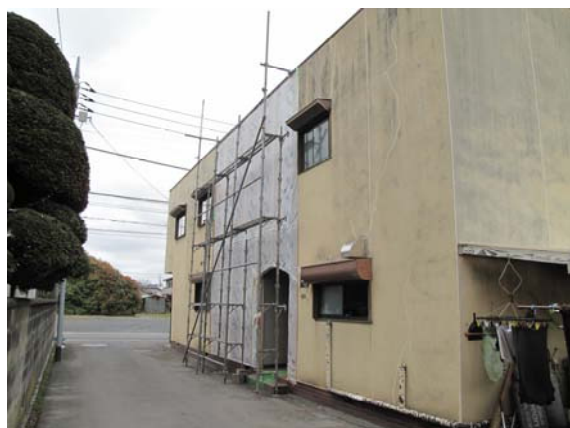
写真12 外装材被害 修理作業様子
