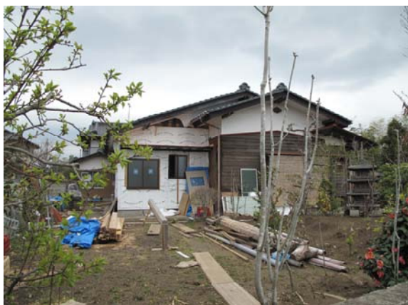
写真 28 外観正面 外装材修繕作業中
