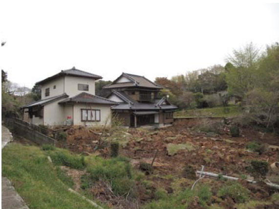
写真 39 木造住宅敷地の土砂崩れ
