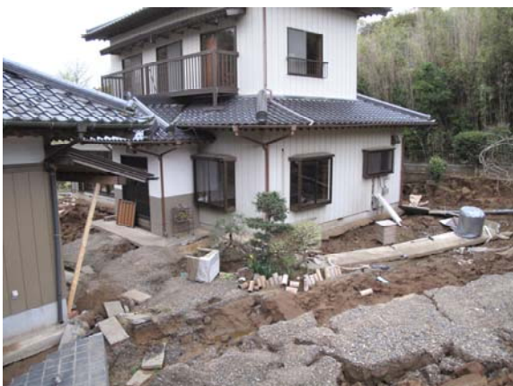
写真 41 土砂崩れによって建物が移動
