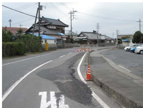
写真 27 車道陥没の修繕
