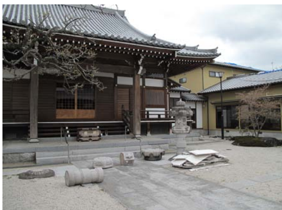
写真9 大宮小学校裏 西方寺 燈籠の転倒
