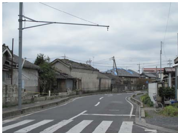
写真14 蔵 屋根瓦のずれ
