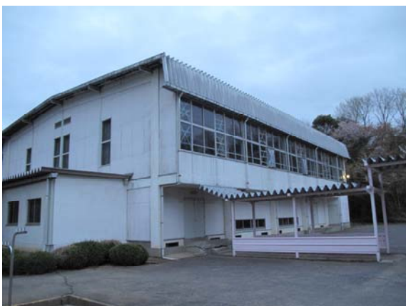
写真 47 体育館窓ガラスの破損
