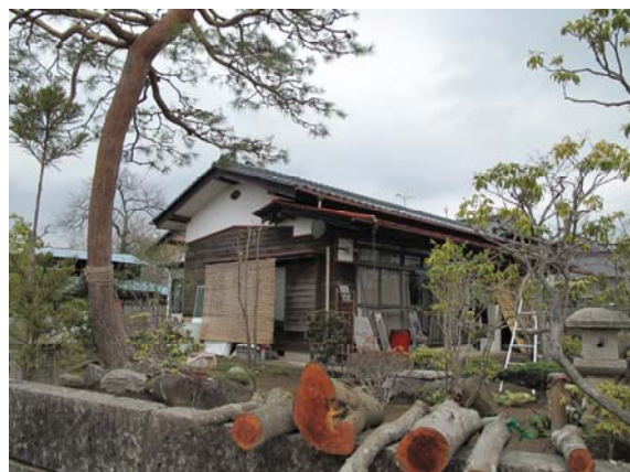
写真 29 外観斜め正面
