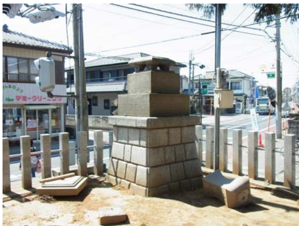
倒壊した灯籠
