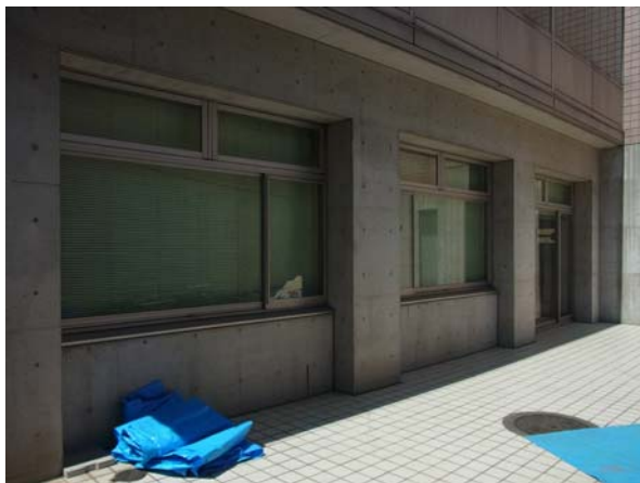
1階の純ラーメン構造部分
