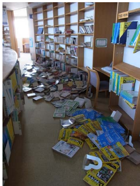
3階における本の落下状況
