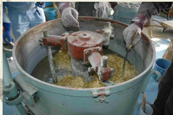
ダクトル®の現場混練
