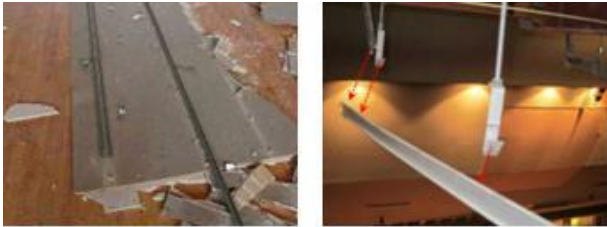
(a)野縁と石膏ボードの落下 (b)ハンガーの開き
