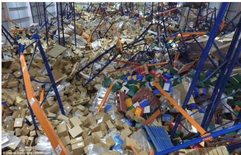
図1 フォークリフトの衝突事故後の様子[1]
