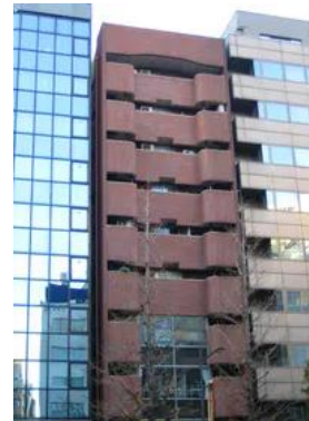
図-1 隣接したビルの様子 (東京・銀座一丁目)
