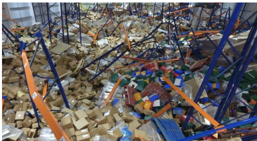
図-2 ラック崩壊事故後の被害の様子[1]
