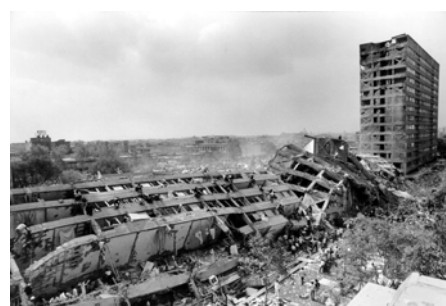
図-2 1985年メキシコ地震において倒壊被害を受けた Nuevo Leon 棟 (写真: Marco Antonio Cruz)
