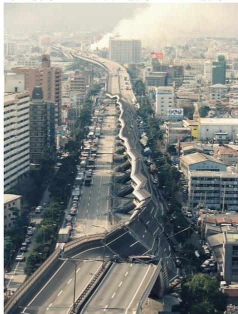
図1 倒壊した18径間PCゲルバー橋[1]
