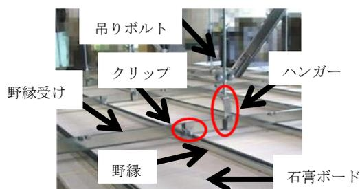
図1 鋼製下地在来工法天井
