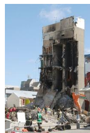
図-2 崩壊後の CTV ビル (出典: 東北新聞)
