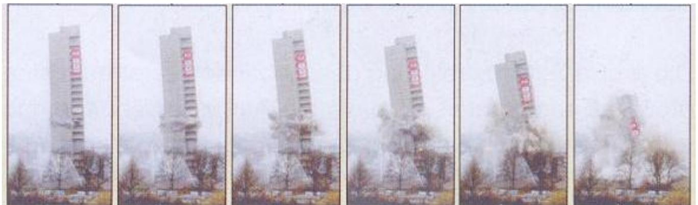
図4 ハーゲン貯蓄銀行ビル発破解体時の崩壊過程
