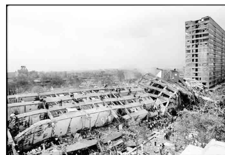
図3 崩壊後の Nuevo Leon 棟 (奥は南棟) (写真: Marco Antonio Cruz)
